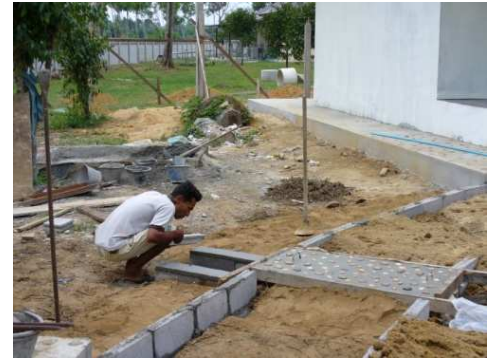
Wasserdurchführung unter dem Gehweg
